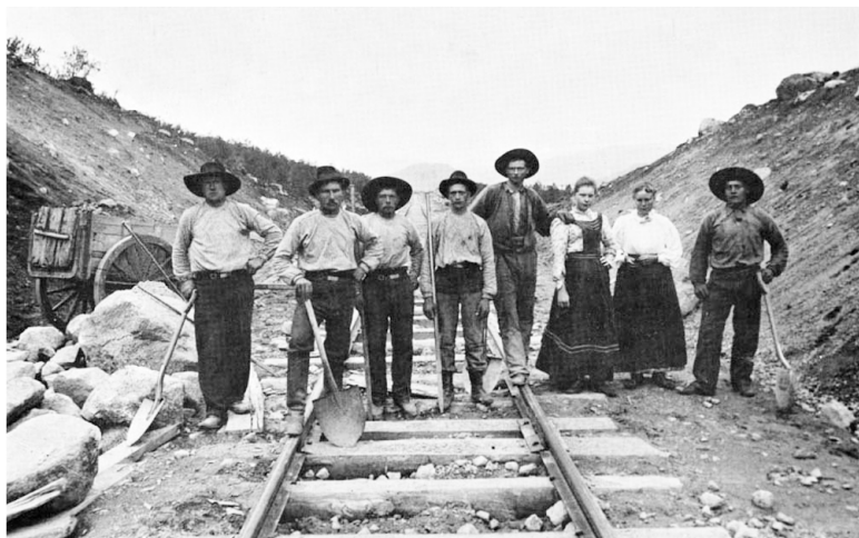
Detta är ett fotografi från anläggningen av Malmbanan. Fotot är daterat 1899.
